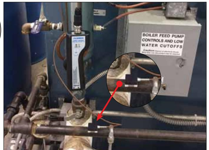
Figure 8 : Sonde 88401K mesurant la température de la conduite
